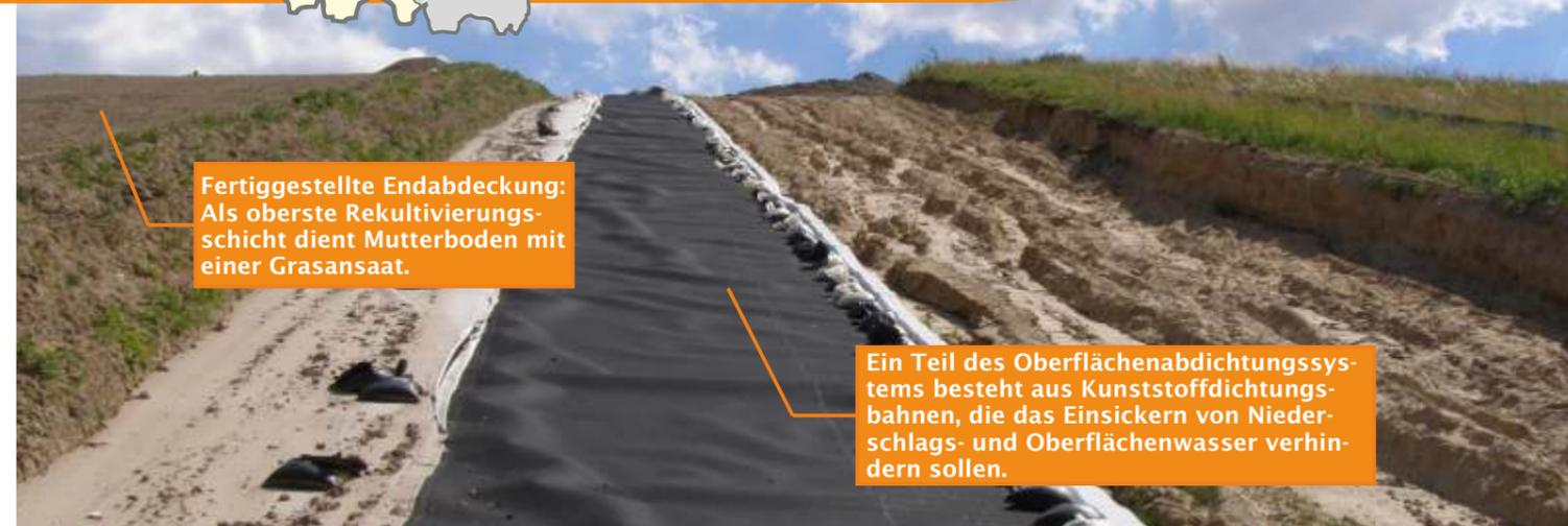
Fertiggestellte Endabdichtung: Als oberste Rekultivierungsschicht dient Mutterboden mit einer Grasansaat.
